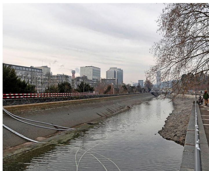
Wegen Bauarbeiten wurde das Wasser abgesenkt. Foto: Sabina Bobst
